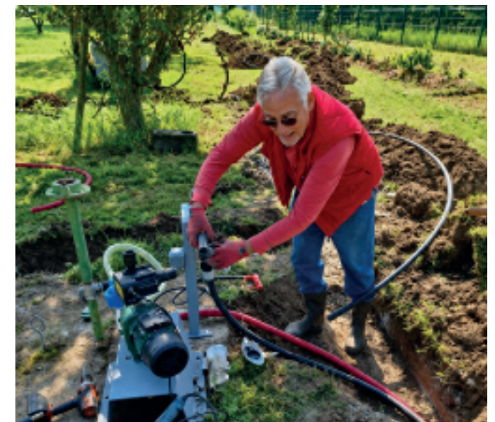
Installation du système d'arrosage : raccordement et mise en place des conduites qui alimenteront les «goutteurs».
