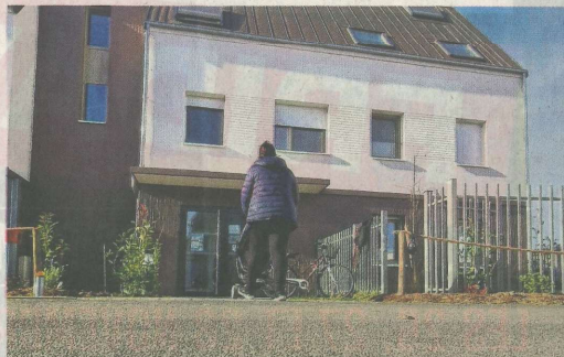
Réunion de deux appartements en rez-de-jardin d'une construction neuve, la crèche peut accueillir 20 enfants sur un plateau de 188 m². Photo Guillaume Erckert
