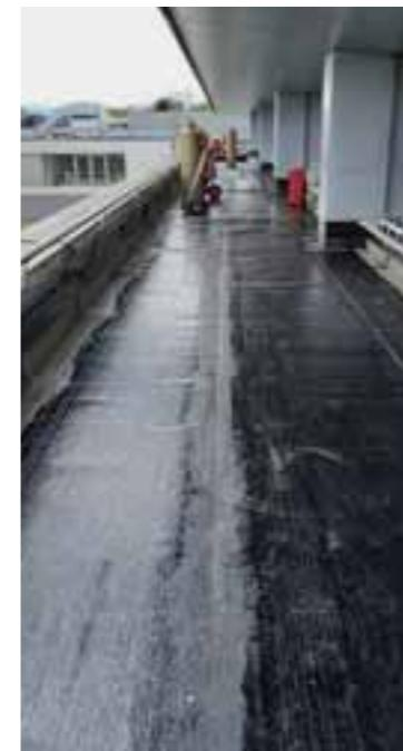
Rénovation coursives toiture salle de basket : reprise isolation et étanchéité par l'entreprise Soprema
