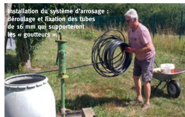
Installation du système d'arrosage : déroulage et fixation des tubes de 16 mm qui supporteront les « goutteurs ».
