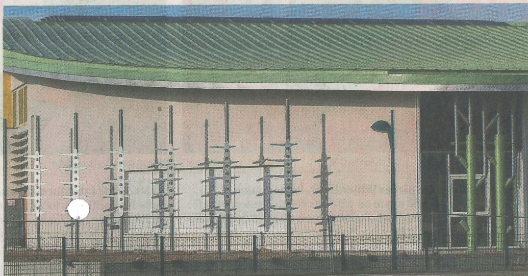
Sept bâtiments publics (ici le périscolaire), bientôt huit, sont équipés de panneaux photovoltaïques qui en alimentent d'autres dans la commune. Photo Cédric Joubert
