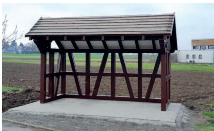
Abribus en cours de réhabilitation
