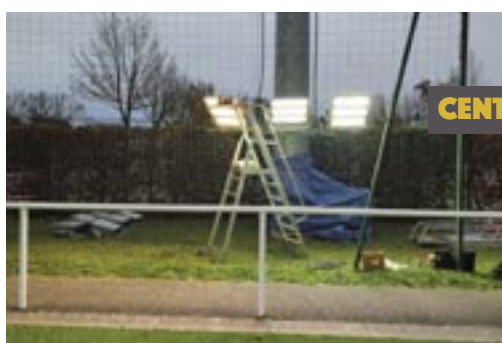
Remplacement des luminaires des terrains de football honneur et Samson Lejeune par luminaires led
