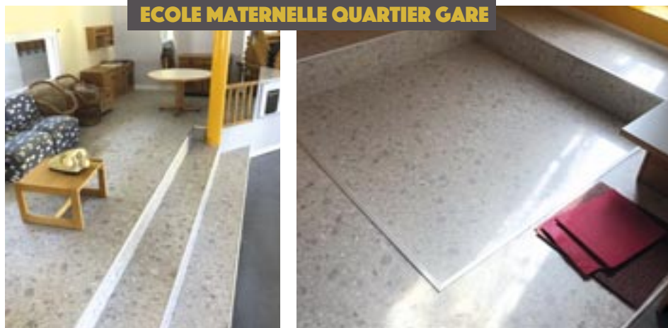
Suppression des sols en moquette par l'entreprise Schoeffter
