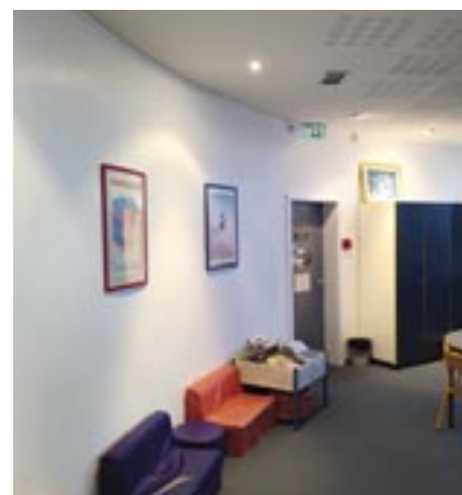
Reprise de la peinture de la bibliothèque par l'équipe bâtiment
