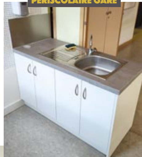
Fabrication d'un meuble avec évier par l'équipe bâtiment
