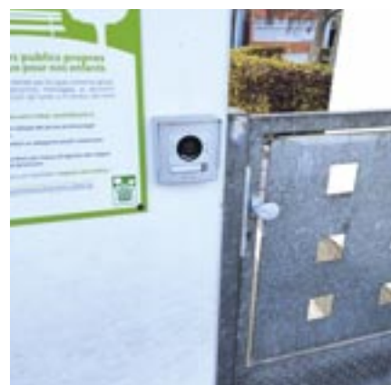
Mise en place d'un interphone sur le portillon d'entrée par l'entreprise Spie
