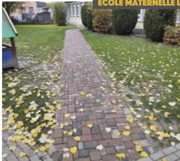
Cheminement piéton jusqu'à la classe de Mme Roy réalisé par l'équipe travaux généraux
