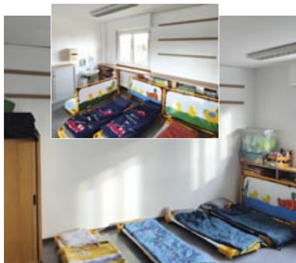
Remise en peinture de la salle de sieste par le peintre de l'équipe bâtiment
