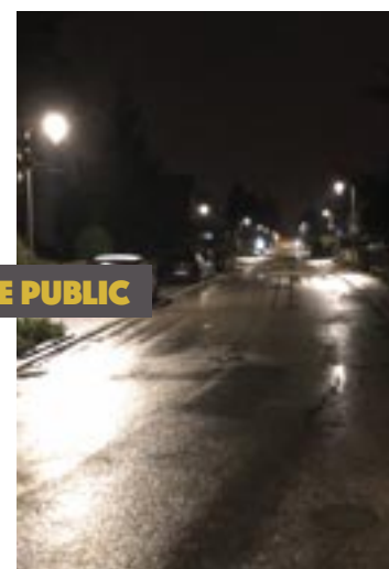
Remplacement des candélabres rue de la Gare et rue de Verdun
