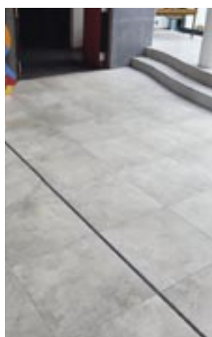
Remise en état du carrelage du sas d'entrée par l'entreprise Koehler
