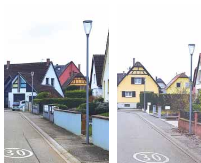
Remplacement des poteaux et des luminaires rues de Barr, Obernai et Benfeld.
