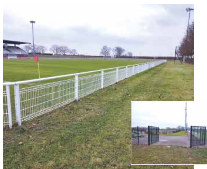
Remplacement d'une partie de la main courante du terrain d'honneur et remplacement du portail entre le terrain d'honneur et le terrain Berst.
