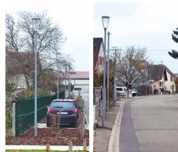
Renouvellement du réseau d'éclairage rue du Tramway et rue des Fleurs
