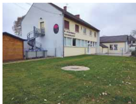
Remise en état du terrain de l'école maternelle Les Coquelicots
